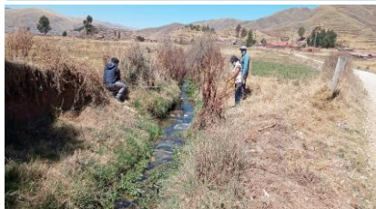
FOTO 06: Quebrada Occopampa Chaupipampa Mayo Rosasani Llaia cauce colmatado, requiriendo la limpieza de sólidos asentados arcilla n el fondo del cauce.
