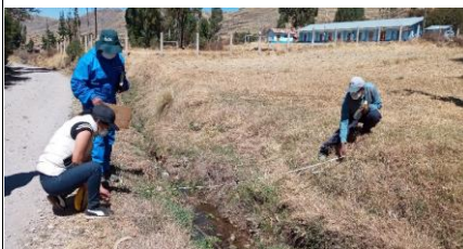
FOTO 05: Cauce colmatado y estrangulado, el cual interrumpe el normal flujo del agua, afectando a la carretera trocha carrozable Tugasuca a
